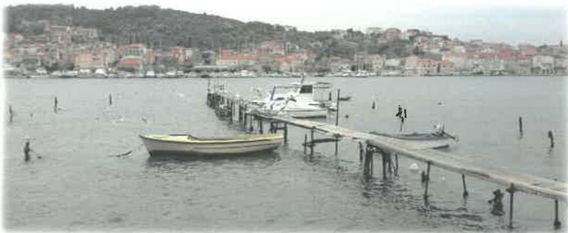
Prostor na Brigima prije početka izgradnje lučice
