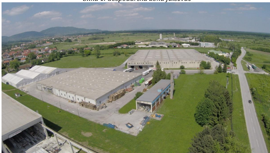
Slika 1. Gospodarska zona Jalševac
