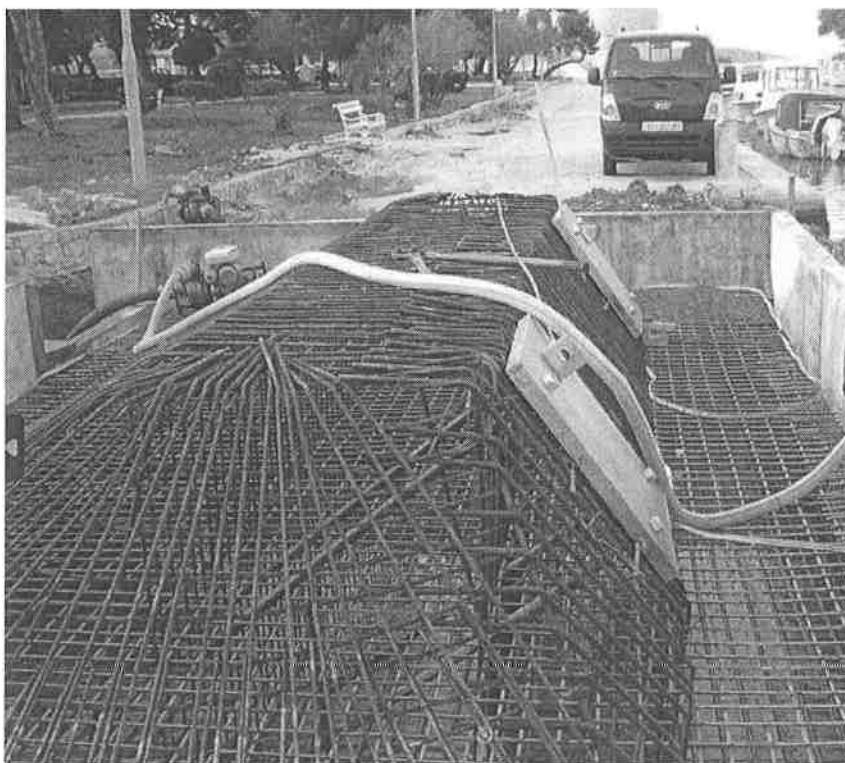
Slika 1: Prikaz postojećeg temelja prilikom izgradnje
